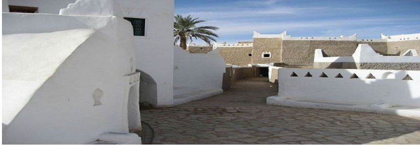
الصورة رقم (12) أبنية مدينة غدامس القديمة
