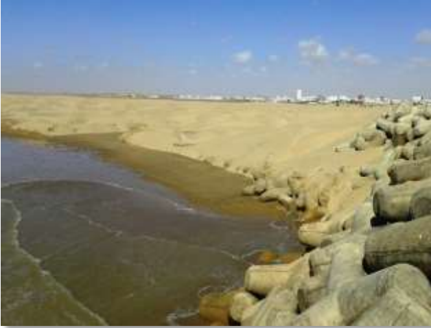
الصور رقم 9 - 10 : الصخور الخرسانية الاصطناعية بالواجهة الشمالية لميناء العيون (تصوير شخصي 2018)
