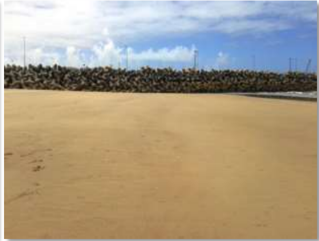
الصور رقم 9 - 10 : الصخور الخرسانية الاصطناعية بالواجهة الشمالية لميناء العيون (تصوير شخصي 2018)
